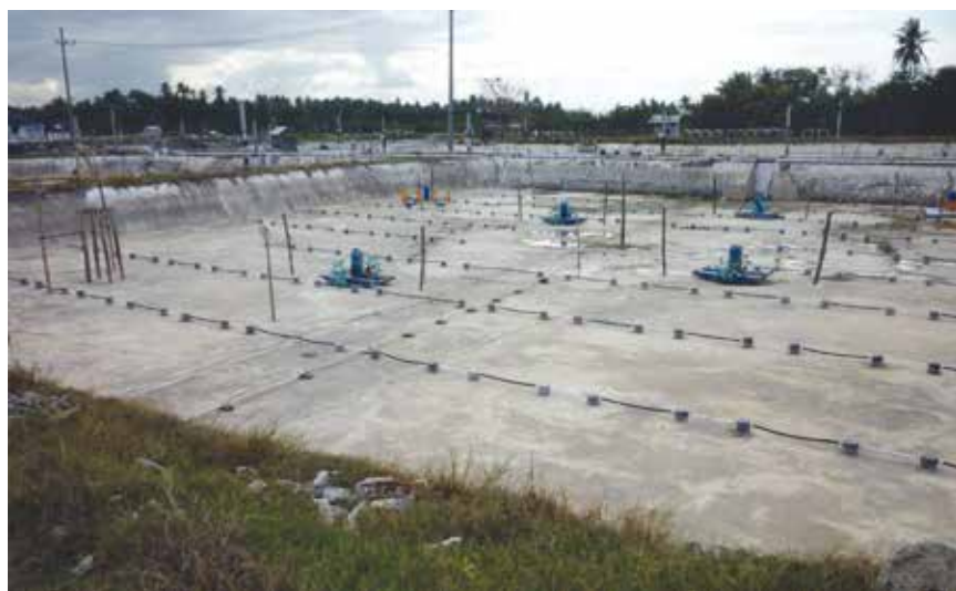
Figura 2: Adaptación de una piscina intensiva para el cultivo de camarón bajo condiciones de AHPND/EMS. Se observa una profundización de la piscina, incremento del sistema de aireación con la instalación de difusores en el fondo, cimentación del fondo e instalación de un sistema de drenaje en el centro de la piscina para retirar el material orgánico acumulado (Foto cortesía Dr. Pornlerd Chanratchakool).
